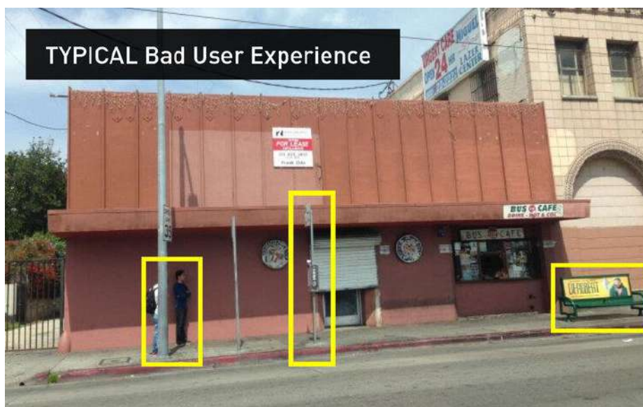
Figura 87 - Esempio di una condizione di inadeguatezza della fermata
